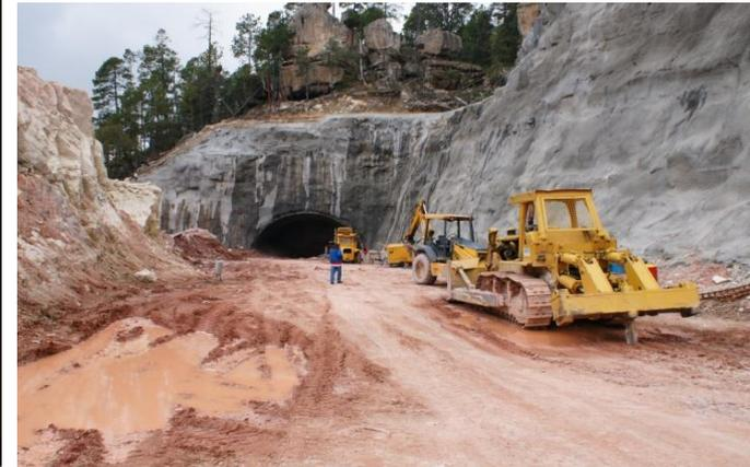
Los túneles se proyectaron de dos carriles de circulación con 3.5 m. de ancho y acotamientos de 2.0 m., con banquetas de servicio de 0.5 m.
