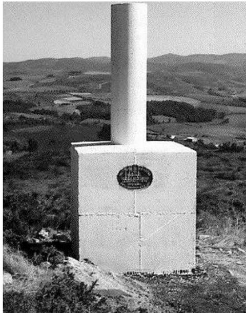
*Fig. 1: Hito de hormigón que sirve de base a un vértice geodésico. Fuente: Instituto Geográfico Nacional (<http://www.ign.es>)*
