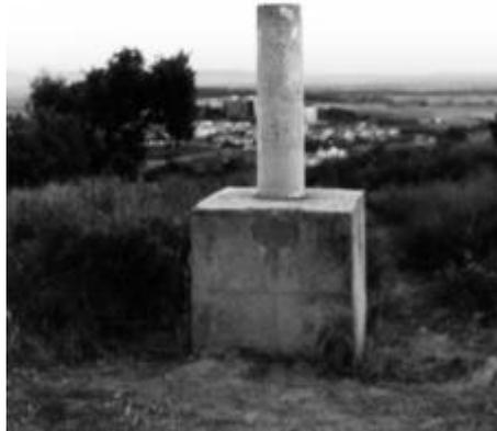
*Fig. 27: Vértice geodésico de tercer orden, denominado "Sierrilla". Situado en las proximidades de la zona de la Sierrilla (Cáceres), cuenta con una altitud de 521,20 metros y unas dimensiones reglamentarias para este tipo de señales (base prismática cuadrangular de 1 metro de lado y pilar cónico de 0,30 metros de diámetro y 1,20 de altura). Este vértice pertenece además a la red IBERIA95*
