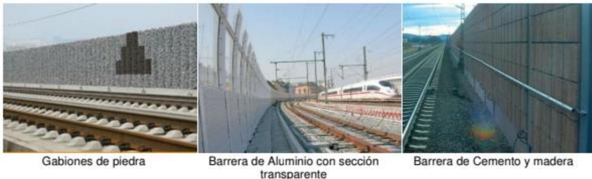
Figura 20. Ejemplos de barreras acústicas de altura completa.<sup>[6]</sup>
