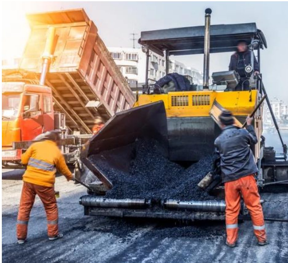
Figura 4.1. Finisher en operación.
