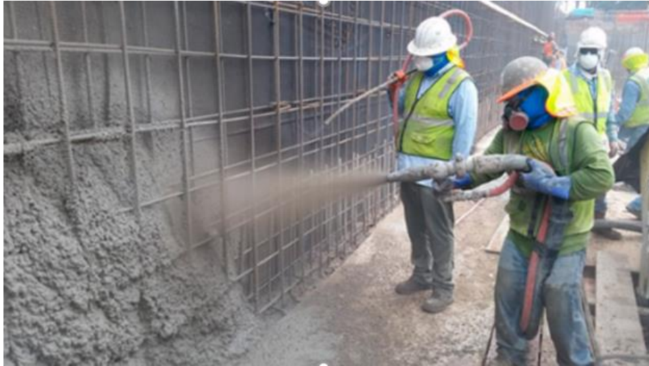
Figura 2.5 Lanzado de concreto.
