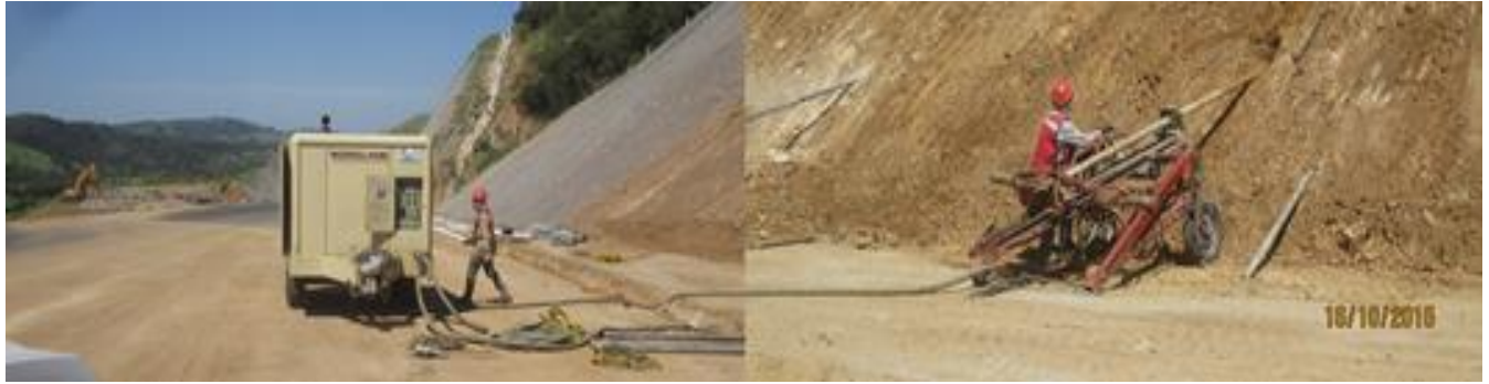
Figura 1.3 Wagon drill con su correspondiente equipo de aire comprimido. Fuente: Fotografía propia. Construcción carretera Jala-Compostela.
