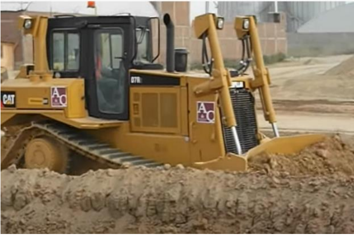
Figura 1.14. Tractor en excavación y empuje de material.
