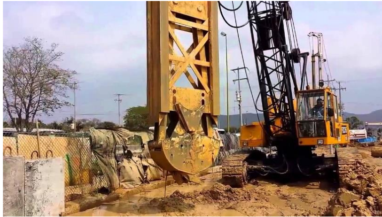
Figura 4.2 Cucharón de almeja guiada en excavación de muro Milán. Fuente: www.youtube.com
