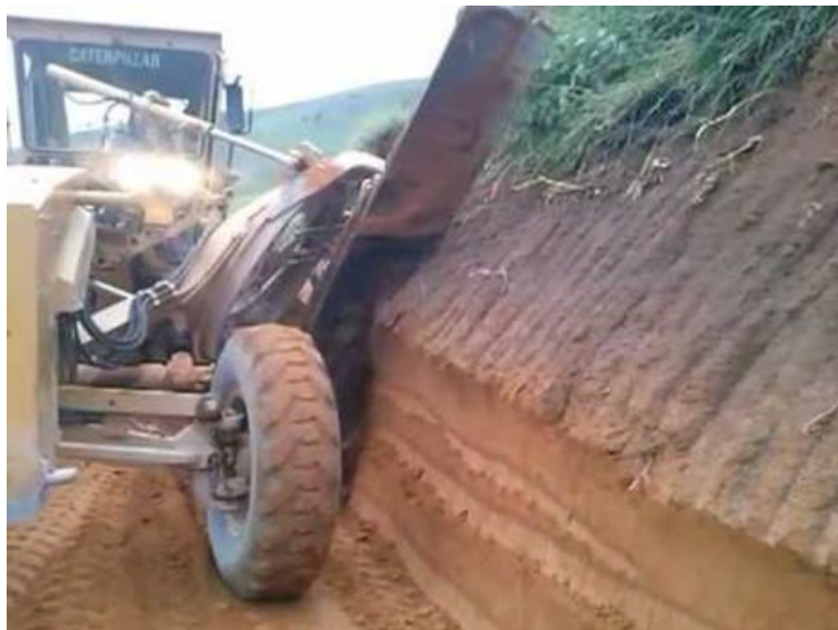
Figura 4.4 Motoconformadora en afine de talud.
