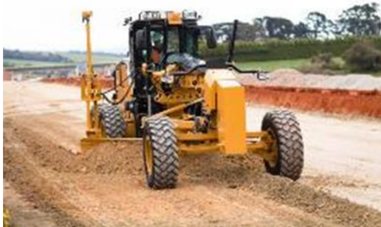
Figura 4.4 Motoconformadora extendiendo material.
