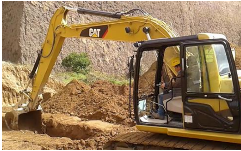
Figura 3.8 Excavación de zanja con excavadora.
