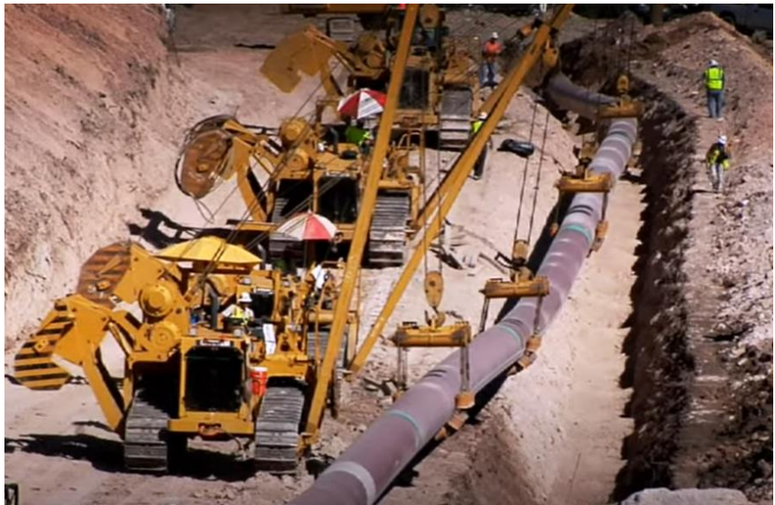
Figura 1.16. Tractores tiendetubos trabajando coordinadamente.
