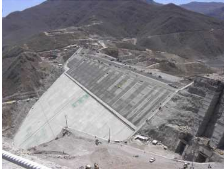
Figura 1.1 Construcción de la cortina en un proyecto hidroeléctrico..
