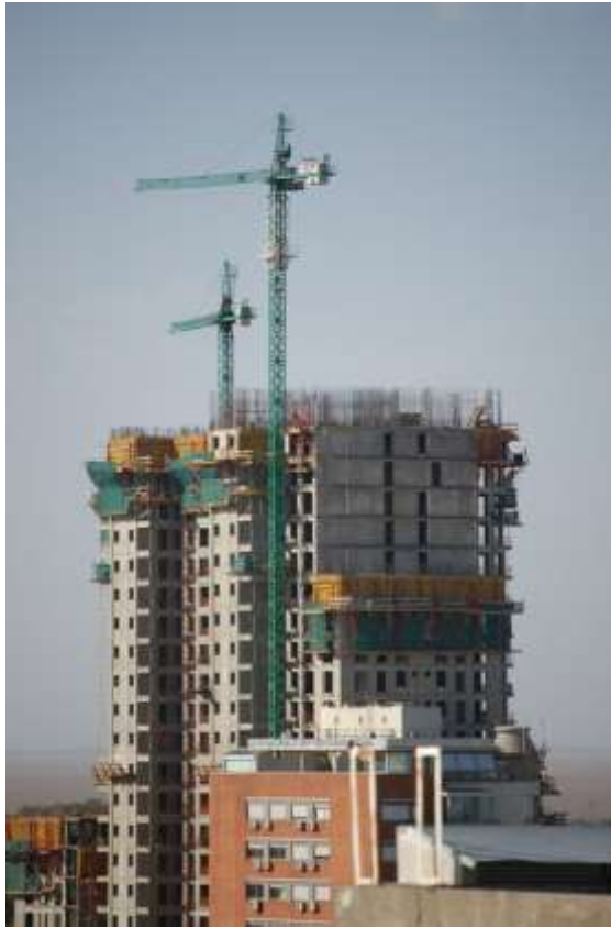
Figura 1.3 Construcción de edificio.
