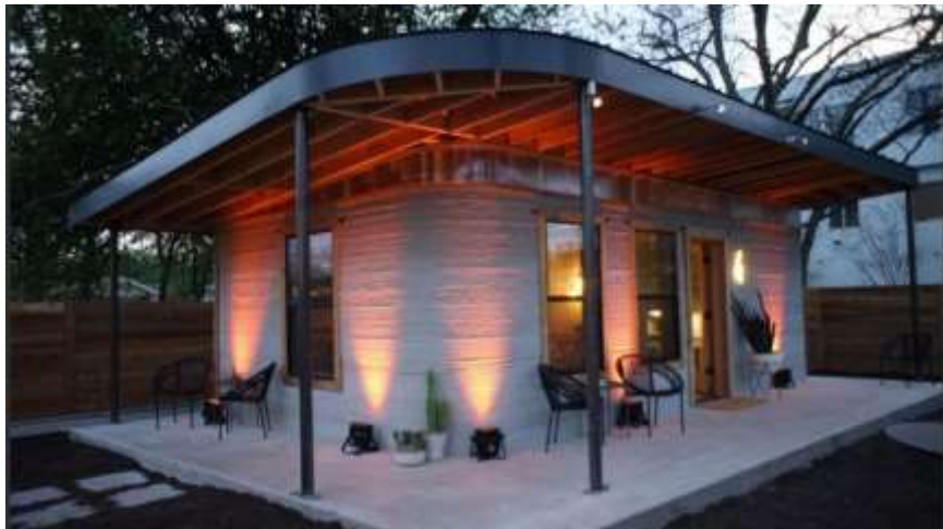
Figura 5.2 Modelo clásico de vivienda con impresión 3D (Foto ICON). Fuente: https://www.cnet.com/es/noticias/impresora-3d-construccion-casas-el-salvador/
