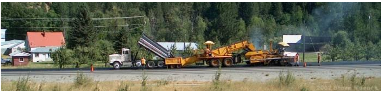
TREN DE LAYDOWN QUE DEMUESTRA EL CARRO, MTV Y EL PAVIMENTADOR DEL ASFALTO
