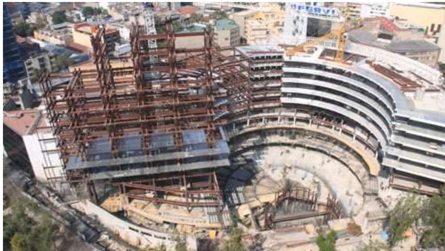
Figura 31. Vista panorámica frontal del desarrollo de la superestructura de la nueva sede del Senado
