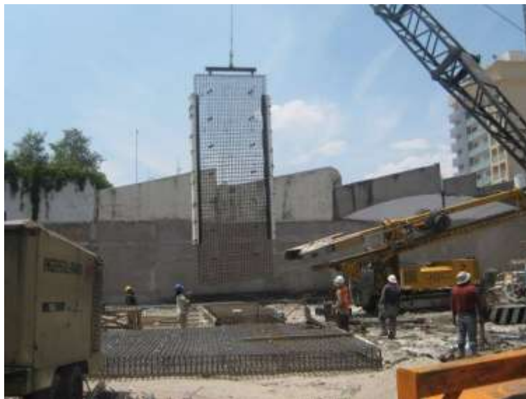
Figura 28. Colocación de diafragma para un cajón de cimentación con muro Milán
