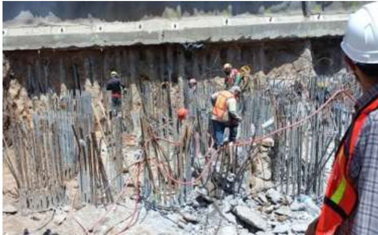
Figura 20. Descabece de pilas de cimentación
