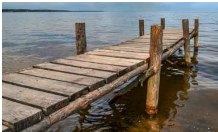
Figura 5. Pilotes de madera
