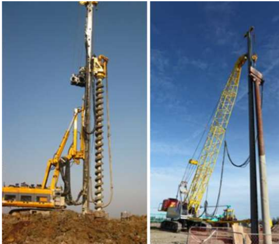
Figura 14. Perforación e hincado de pilote de concreto
