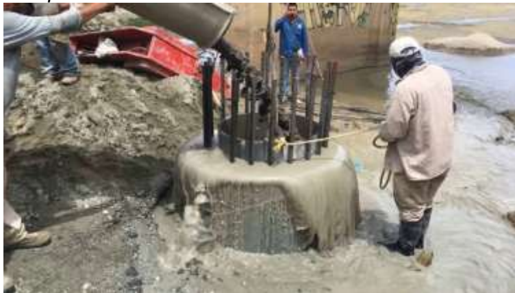
Figura 19. Colado de pila de cimentación
