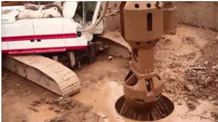
Figura 17. Uso de lodo bentonítico en una perforación
