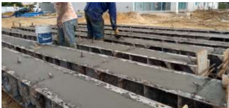
Figura 9. Colado de pilotes
