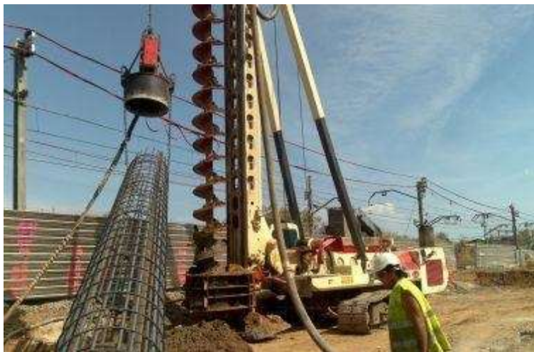
Figura 33. Perforadora montada sobre orugas
