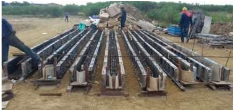
Figura 8. Acero de refuerzo en moldes de pilotes
