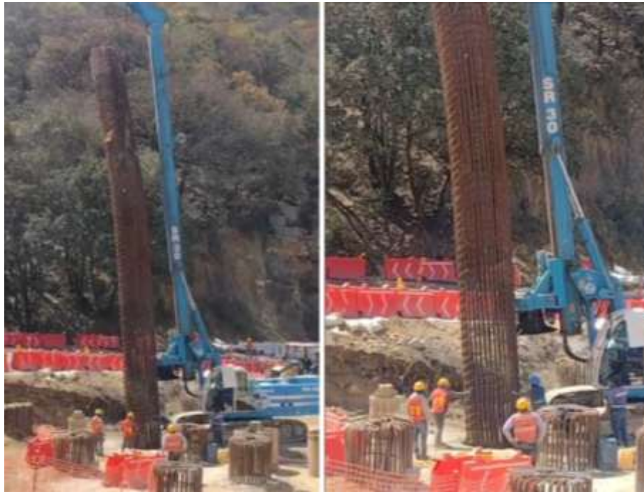
Figura 21. Colocación de armado de refuerzo
