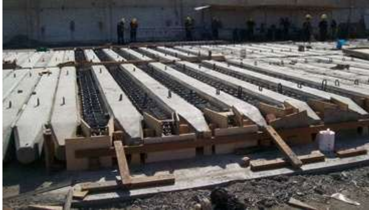
Figura 10. Pilote fraguado listo para el colado de otros pilotes
