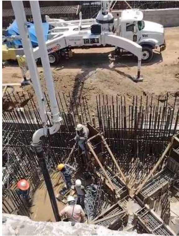
Figura 22. Colado de pila de cimentación
