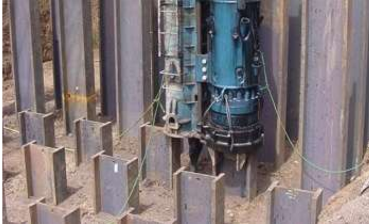
Figura 12. Hincado de perfiles de acero como pilotes
