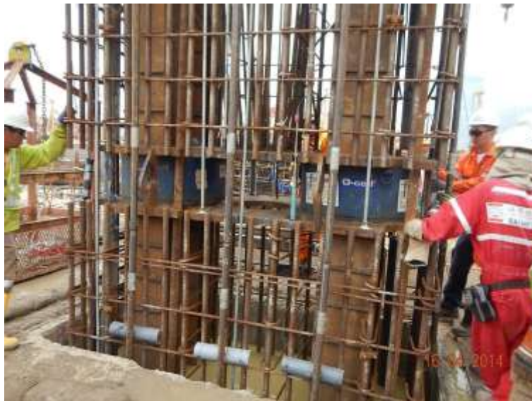
Figura 3. Unión de pilotes
