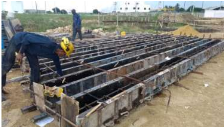
Figura 7. Moldes para colado de pilotes
