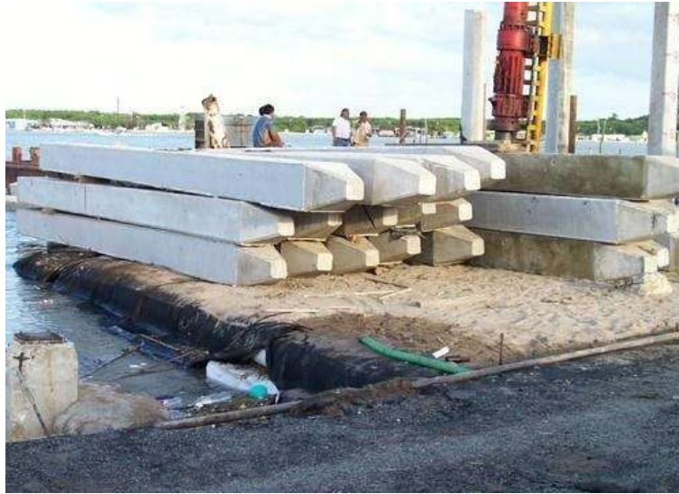
Figura 1. Pilotes de concreto prefabricados
