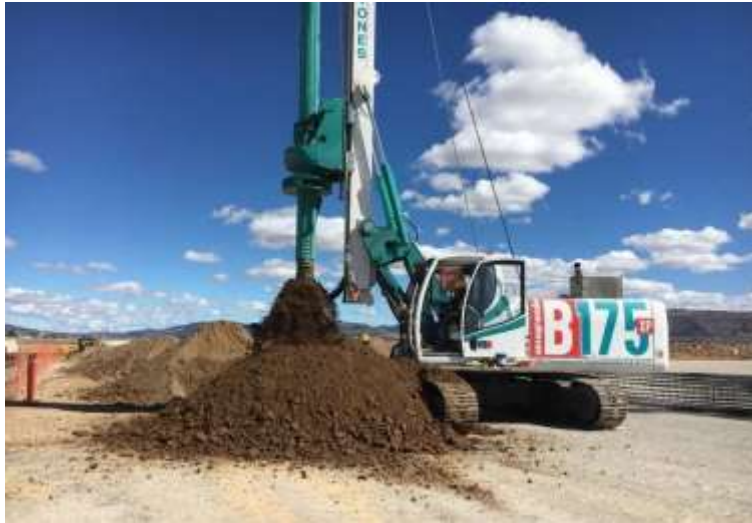
Figura 16. Perforación previa a colocar el acero de refuerzo
