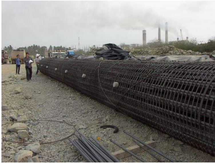
Figura 4. Habilitado de acero de refuerzo en pilas
