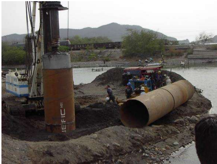
Figura 3. Cimentación profunda a base de pilas
