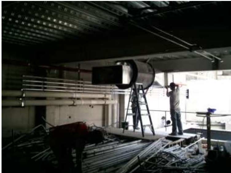
Figura 15. Instalación de aire acondicionado
