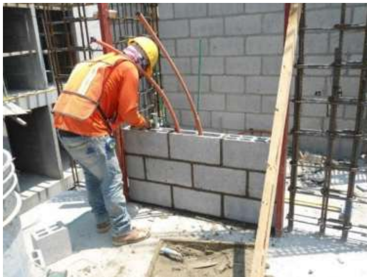
Figura 9. Desplante de muros de mampostería
