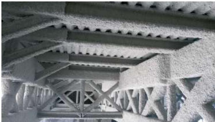
*Nota:* Adaptada de *Soluciones Constructivas Tecwool® F: Tecwool® F – Protección elementos de acero (vigas y pilares)* [Fotografía], por Tecresa Protección Pasiva, S. L., 2024, mercor® tecresa (<https://mercortecresa.com/morteros-tecwool/tecwool-f/proteccion-de-elementos-de-acero>). Todos los derechos reservados.
