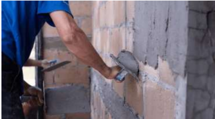
Figura 9. Mortero utilizado en aplanado
