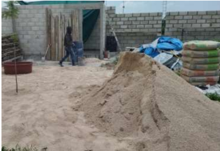
Figura 6. Arena para uso de la construcción de losa en Tlayacapan, Morelos
