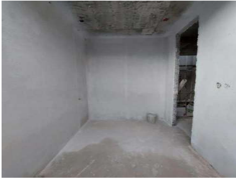
Figura 5. Acabado con mortero de yeso
