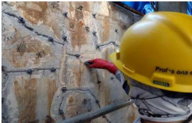
Nota: Adaptada de Mantenimiento Correctivo Inyección de Resina Epóxica [Fotografía], por PSC México, 2024, PSC México (<https://pscmexico.mx/mantenimiento-correctivo-inyeccion-de-resina-epoxica/>).
