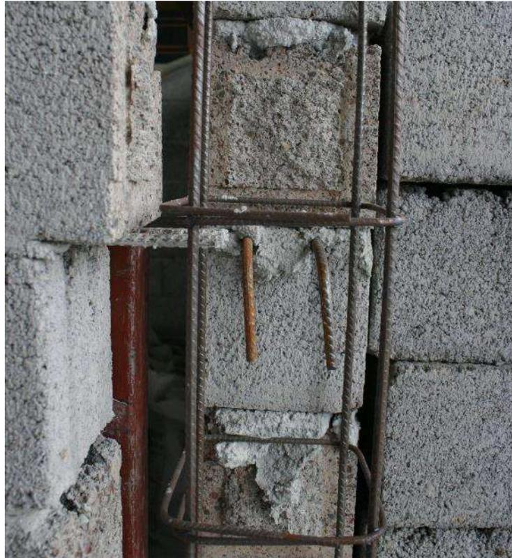
*Nota:* Acero de refuerzo en un muro de mampostería reforzada interiormente con escalerillas de varilla corrugada [Fotografía], por Departamento de Construcción, 2024. Colección personal del autor.
