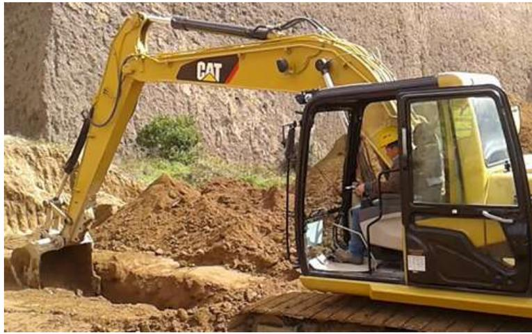
*Figura 3.8 Excavación de zanja con excavadora.*
