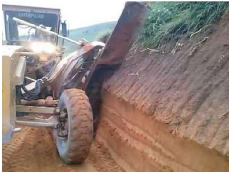
*Figura 4.4 Motoconformadora en afine de talud.*
