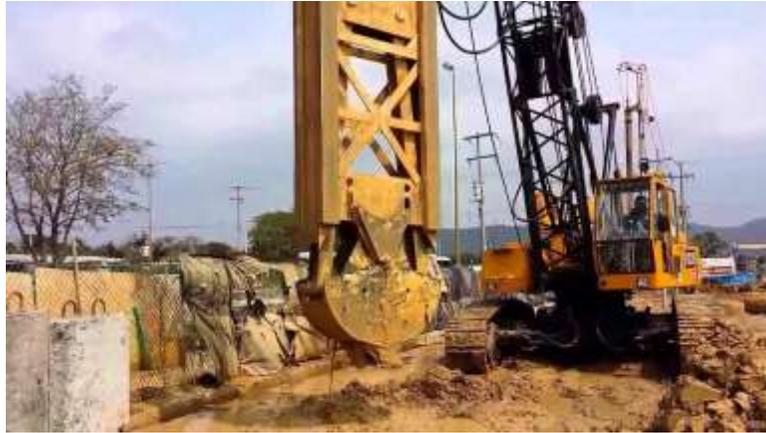
*Figura 4.2 Cucharón de almeja guiada en excavación de muro Milán.
