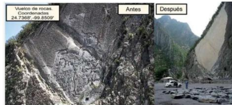
Figura 5: Movimiento en masa en "Los Altos", hacia el sur de Monterrey (Tomado de Salinas-Jasso J. A., et al, 2017).
