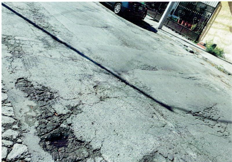
Figura 1. Reductor de velocidad colocado sobre una carpeta asfáltica seriamente dañada.
