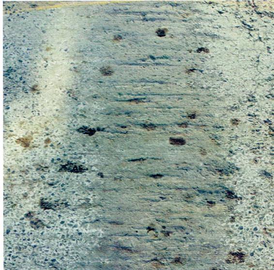
Figura 2. Reductor de velocidad sobre cuya superficie se evidencian los impactos con los vehículos que lo cruzan.
