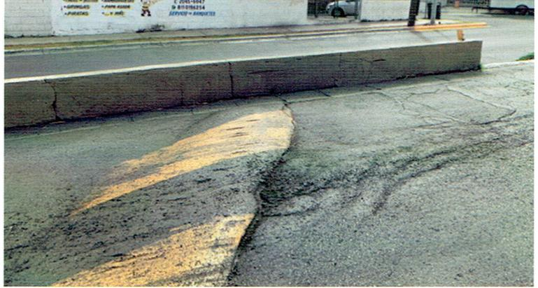
Figura 4. Falla por desplazamiento de la carpeta asfáltica posterior a la colocación del reductor de velocidad.
