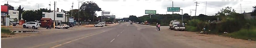
Figura 14. Entronque del km 2+000 del Libramiento desde Tapanatepec con carril central de giro hacia Ocozocoautla
