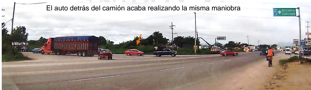
Figura 17. Interferencia entre las trayectorias de distintos vehículos circulando por el entronque del km 2+000 del Libramiento
