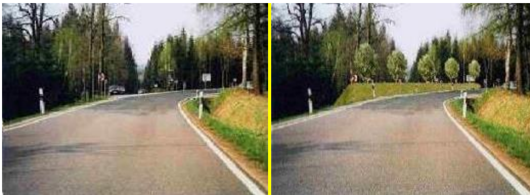
Figura 9-47: Impresión óptica incorrecta (izquierda) y corregida (derecha) corregida por un llamativo terraplén plantado [20]
