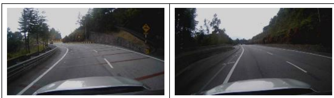
Figura 9-38 - Ancho de carril reducido de 3.25m (izquierda) y proporcionando un hombro más ancho
