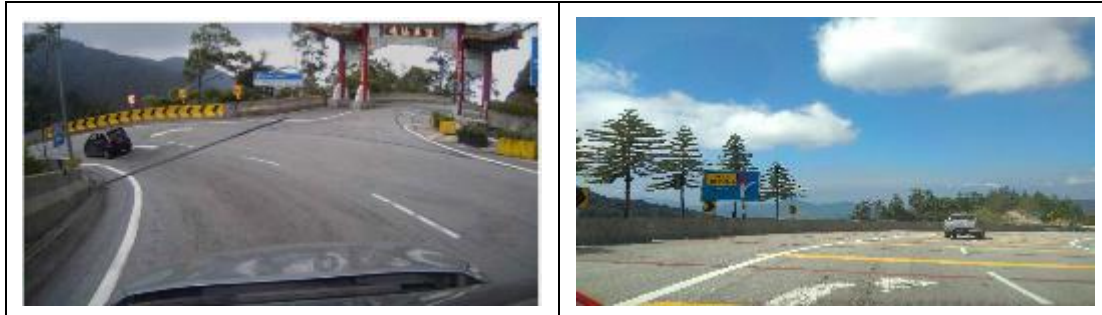
Figura 9-35 - Flechas de Chevron intermitentes (izquierda) y señal de tráfico de la rampa de escape de emergencia
