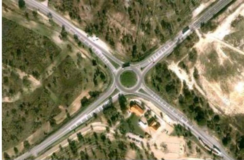
Figura 9-19: Primera fase de intervención y rotonda final
