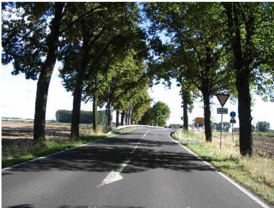
Figura 9-45: Impresiones de una dirección de conducción errónea después de la puesta en servicio de una nueva circunvalación de la ciudad [27]
