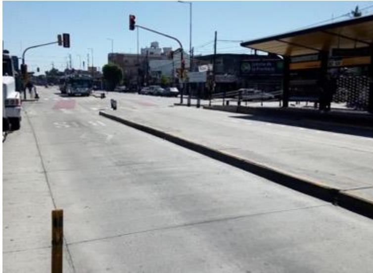
*Figura 40 : Estación BRT con distribución asimétrica de carriles*
