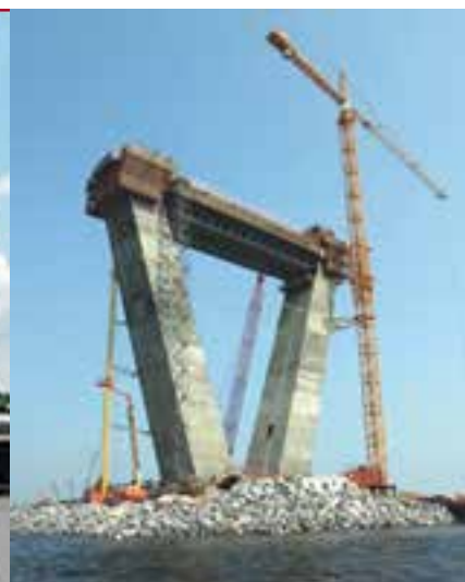
Foto 2B - Isla de rocas colocada en un gran puente que protege a la pila de las colisiones de los buques así como de un acto de terrorismo
