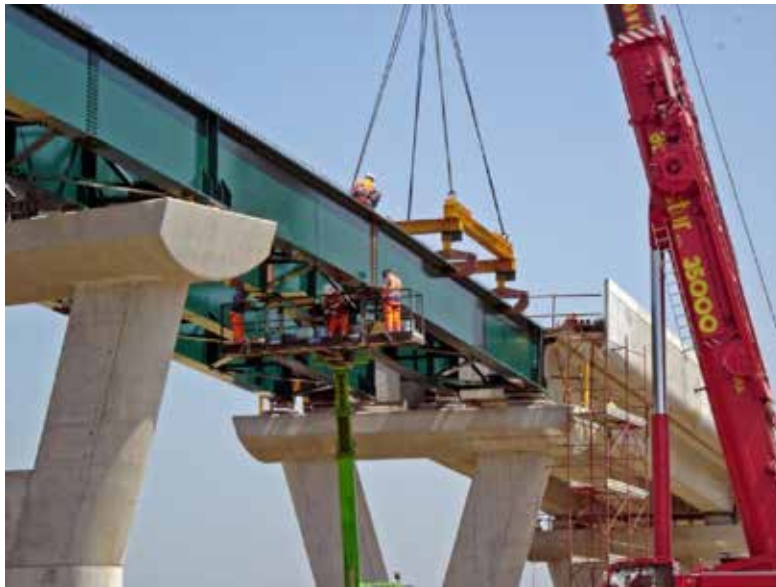
Foto 4 - Construcción de nueva infraestructura
