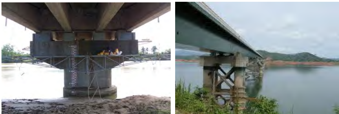
Figuras 4.45 y 4.46. Ejemplo reforzamiento de subestructura
