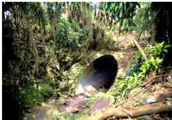
Figura 4.14. Ejemplo de alcantarilla
