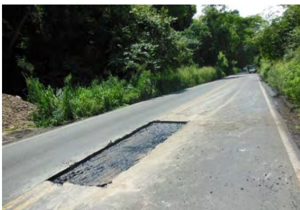
Figura 4.1. Cajeo del bache
