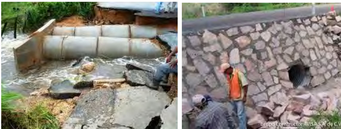
Figuras 4.17 y 4.18. Ejemplo de reparación de obras de drenaje
