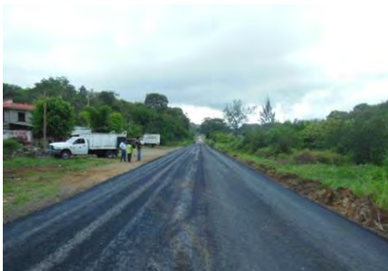
Figura 4.5. Riego de liga con emulsión, previo al tendido
