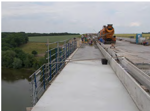
Figura 4.43. Ejemplo de trabajos de reforzamiento en superestructura de puente
