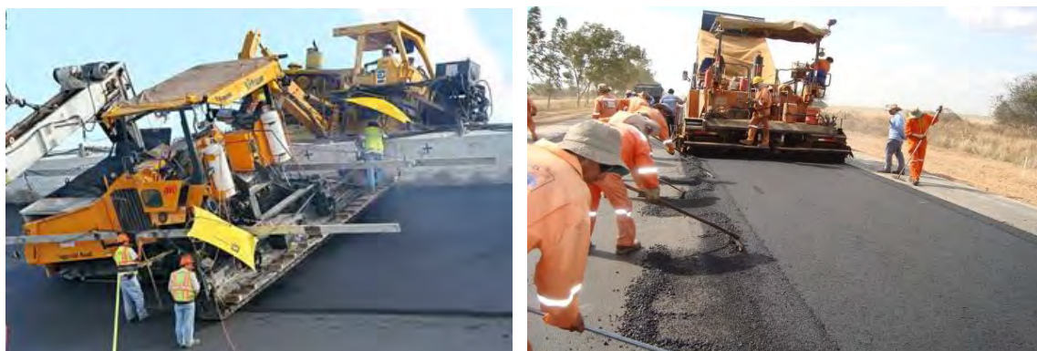
Figuras 4.34 y 4.35. Ejemplo de tendido de carpeta asfáltica
