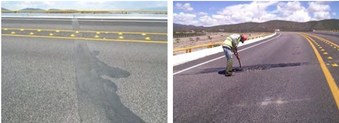
Figuras 4.31 y 4.32. Ejemplo de reparación de juntas transversales
