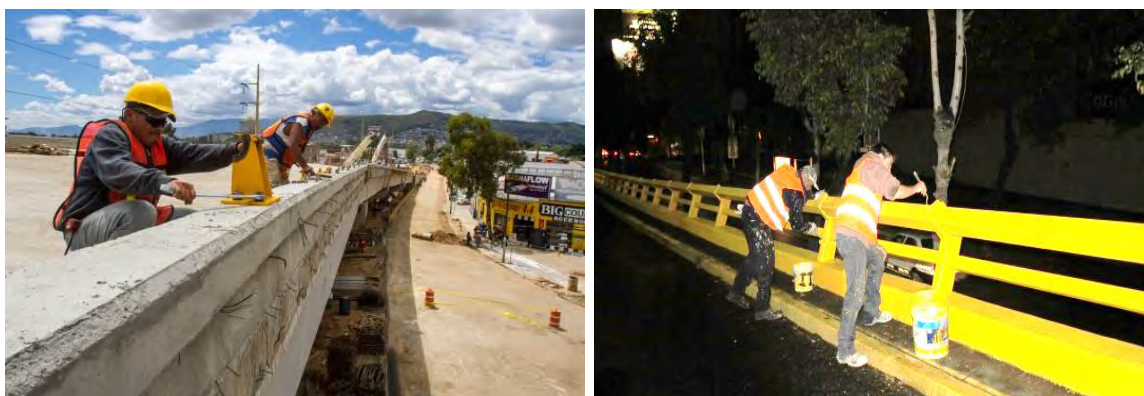
Figuras 4.29 y 4.30. Ejemplo de reparación y pintura de parapetos
