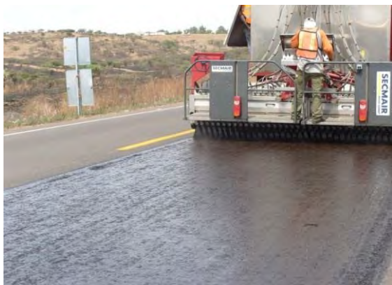
Figura 4.7. Aplicación de riego de liga asfáltico
