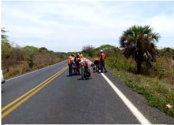
Figura 4.3. Trabajos de sellado con emulsión asfáltica y arena
