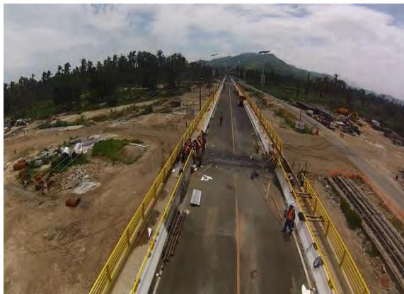
Figuras 4.25 y 4.26. Ejemplo de limpieza de la superficie de puentes
