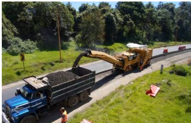
Figura 4.33. Ejemplo de Fresado
