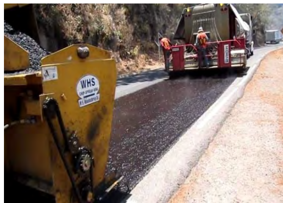
Figura 4.8. Aplicación de material pétreo en riego de sello
