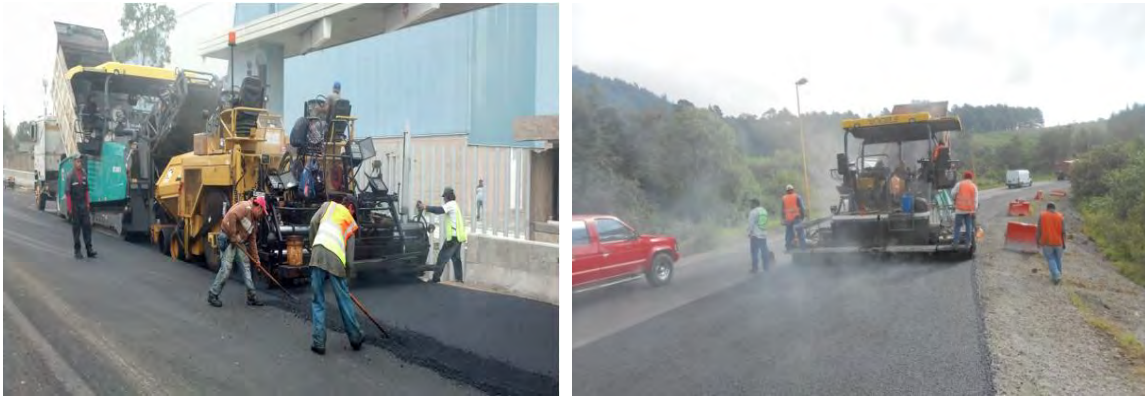
Figuras 4.41 y 4.42. Carpeta de concreto asfáltico
