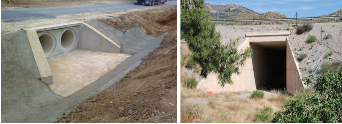
Figuras 4.9 y 4.10. Ejemplos de obras de drenaje
