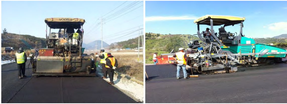
Figuras 4.36 y 4.37. Ejemplo de renovación con pavimentadora
