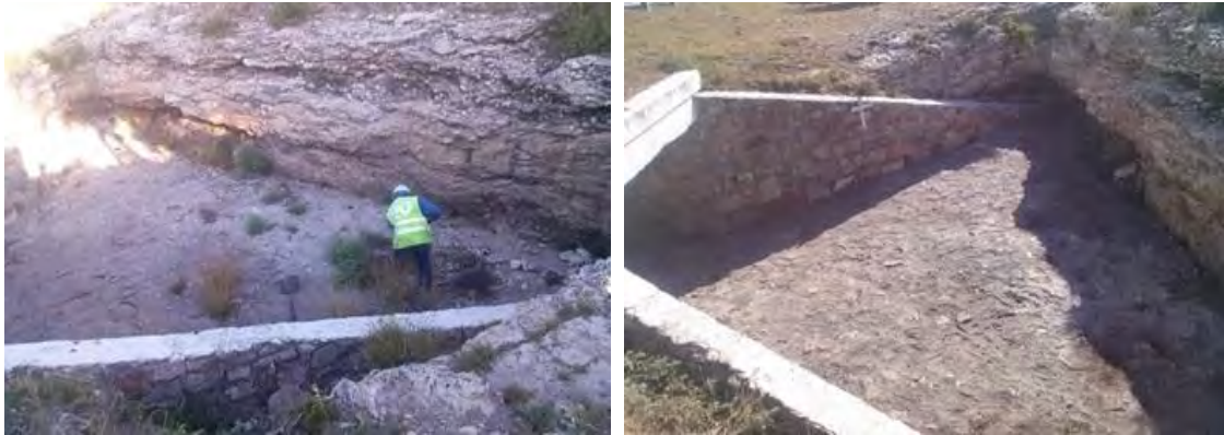
Figuras 4.15 y 4.16. Ejemplo de limpieza de canales de entrada y salida
