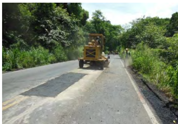
Figura 4.2. Relleno y compactación del bache
