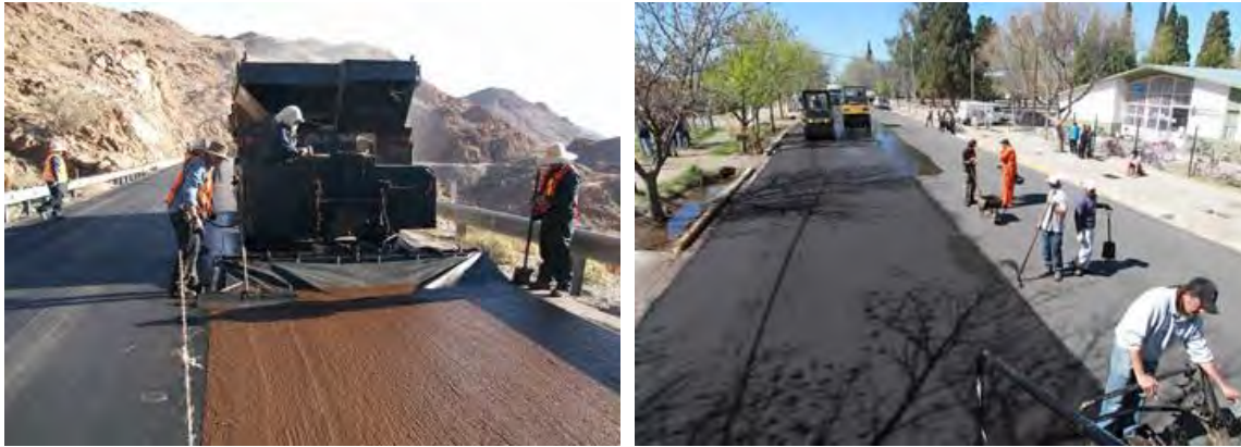
Figura 4.54 y 4.55. Mejoramiento superficie de rodadura Slurry Seal
