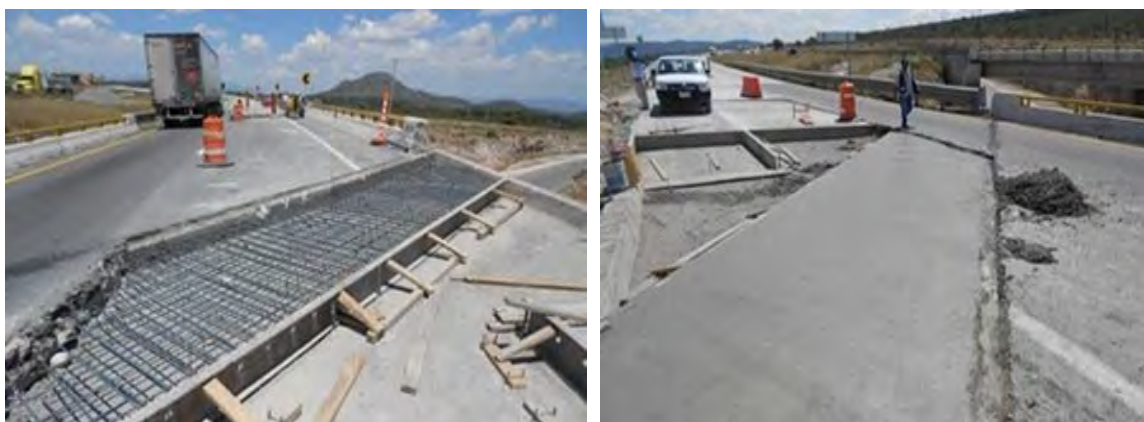
Figuras 4.27 y 4.28. Ejemplo de reparación de elementos de concreto
