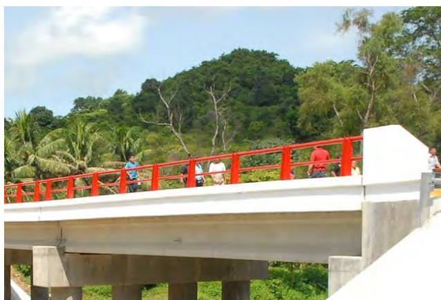
Figura 4.44. Ejemplo de sustitución de superestructura en puentes
