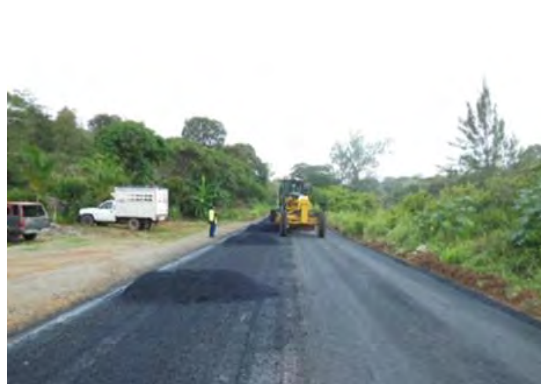
Figura 4.6. Tendido de mezcla asfáltica con motoconformadora en renivelación
