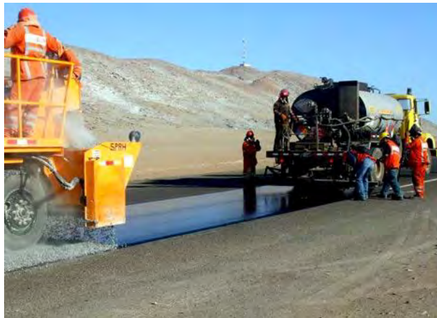
Figura 4.38. Ejemplo de riego de sello
